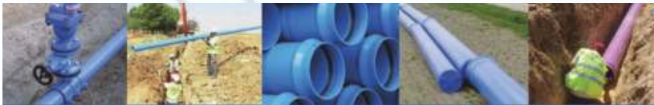
Photo 1 : Pose de canalisations en PVC-BO
