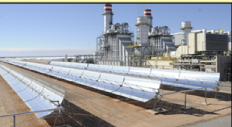
Centrale Thermo Solaire d'Ain Béni Mathar
