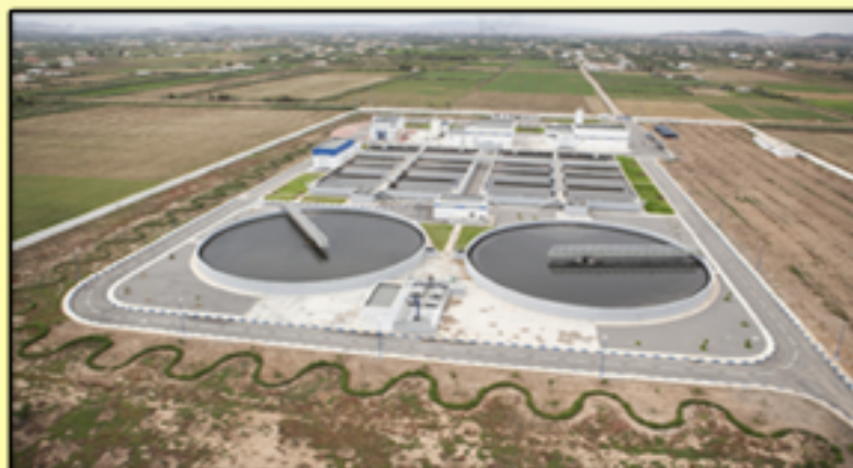
Station d'épuration des Eaux Usées - Grand Nador
